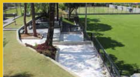
Após a reforma
