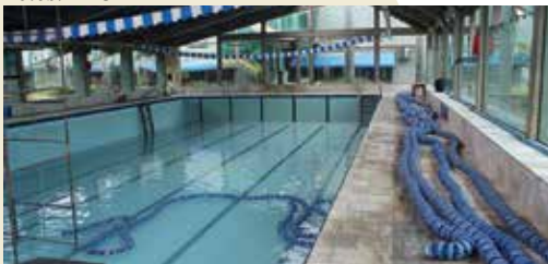
Início da reforma
